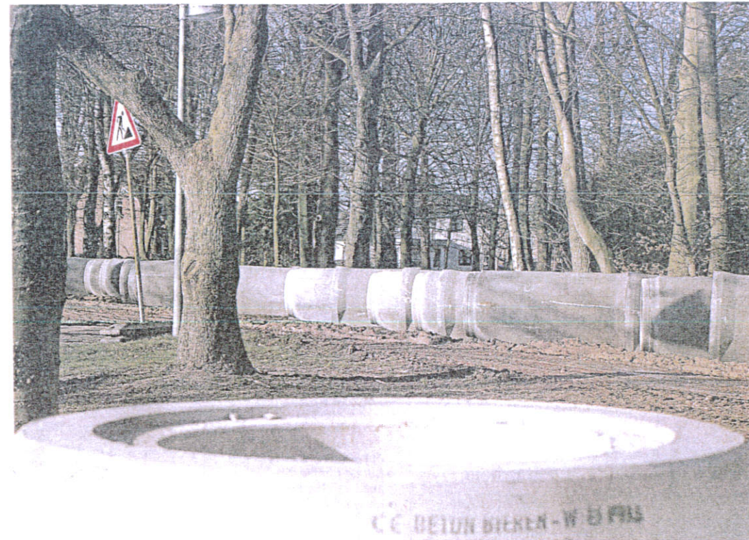
Am Heidenener Biotop sind die Betonrohre aufgereiht, durch die das Regenwasser künftig Richtung Bahnhofstraße fließt. Fotos: Konert
